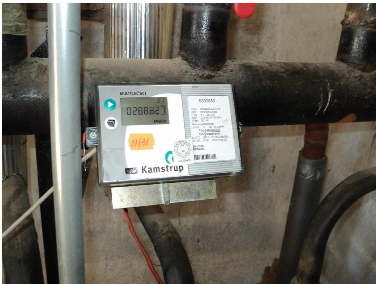
Foto 4. Soojusmõõtja spordihoones, mis mõõdab kooli ja spordihoone tarbimist kokku.
